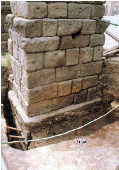
Fig. 167: Pila 116 al inicio de la excavación de la fosa.
