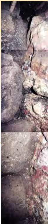
Fig. 173: Montaje en el que se aprecia lo ajustado de la pared de la fosa con respecto a los sillares en el cierre Oeste.
