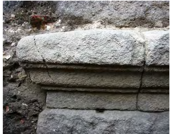
Fig. 66: Sillar de la esquina meridional en donde se aprecia la fractura.
