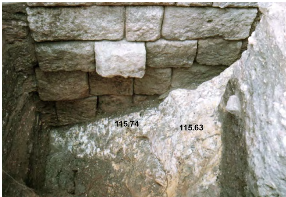
Fig. 59: Aspecto final de la excavación
