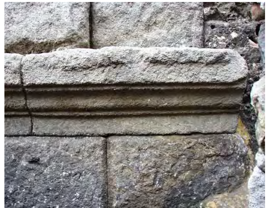
Fig. 68: Sillar de esquina de la cornisa. Véase cómo la moldura se interrumpe.
