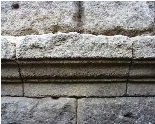
Fig. 67: Sillar central de cornisa.
