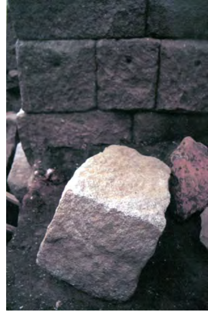
Fig. 146: Detalle del sillar in situ.
