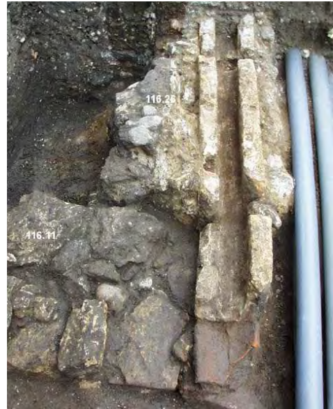
Fig. 82: La atarjea un vez retirada la cubierta de ladrillos.
