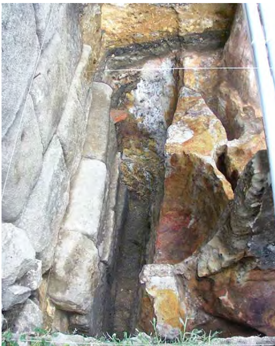
Fig. 123: Fosa de cimentación vista desde el Sur.
