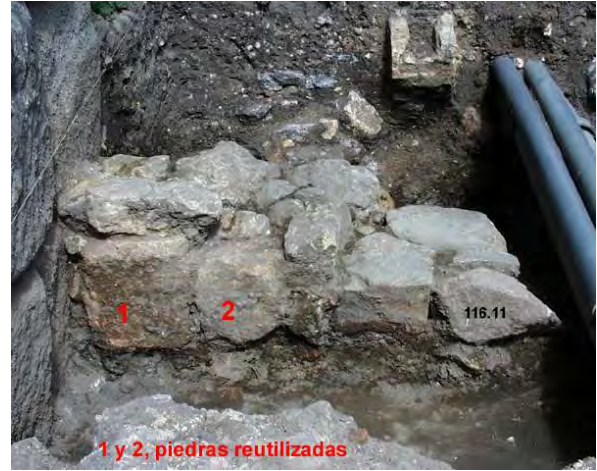
Fig. 90: Tramo W del muro UE 116.11 con la situación de los elementos reutilizados.
