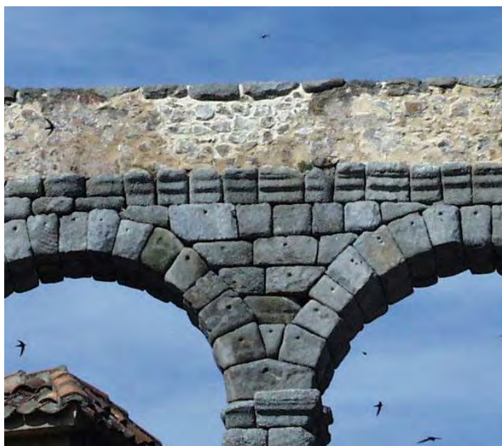
Fig. 11: Zócalo un vez restaurado.
