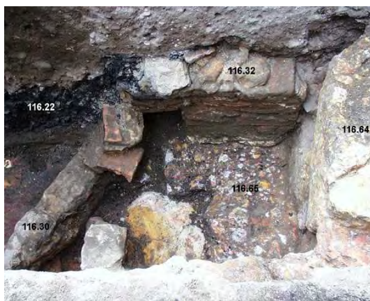
Fig. 79 y 80: Tabiques de ladrillo en el interior del recinto subterráneo.
