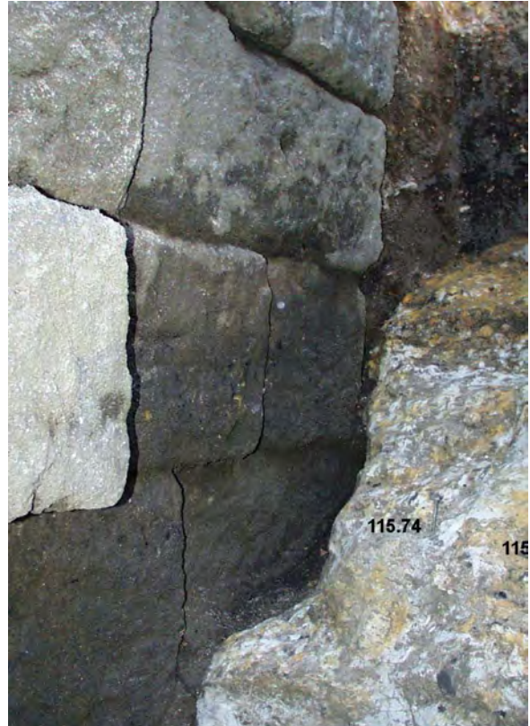
Fig.60 a 63: Los limos arcillosos del terreno natural y la fosa de cimentación de la pila 115
