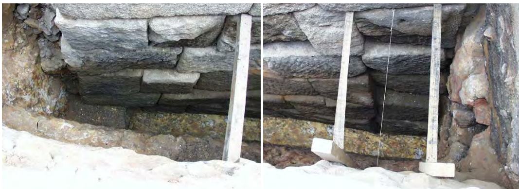
Fig.171: La fosa de cimentación de la pila 116. Pueden observarse los cierres oriental y occidental.
